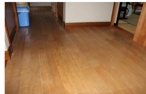
現在の玄関ホールの床。だいが味がでてきました。ブナ15m/m×75m/mを使用。
